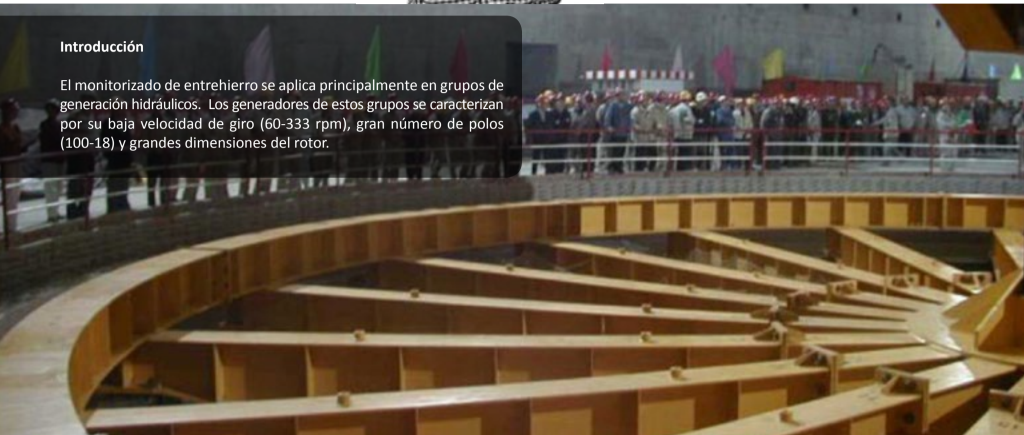
Figura 1: Rotor de un generador hidráulico Fuente: Elaboración propia
