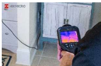
Inspección suelo radiante
